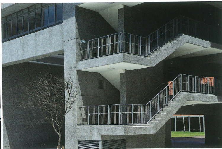
綜合大樓室外梯
