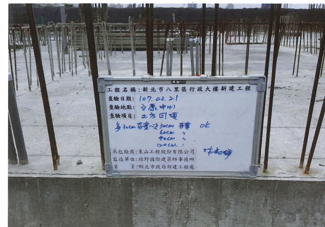
土方開挖回填施工照片
