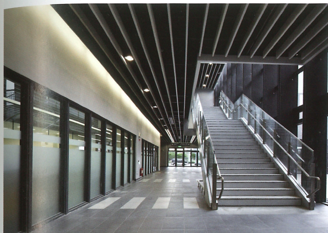
環繞中庭花園的室內洽公樓梯
