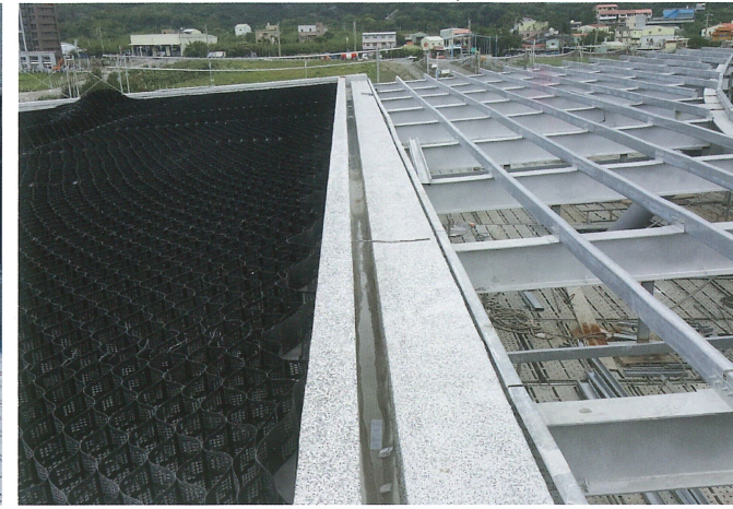
屋頂隔熱層竣工照片
