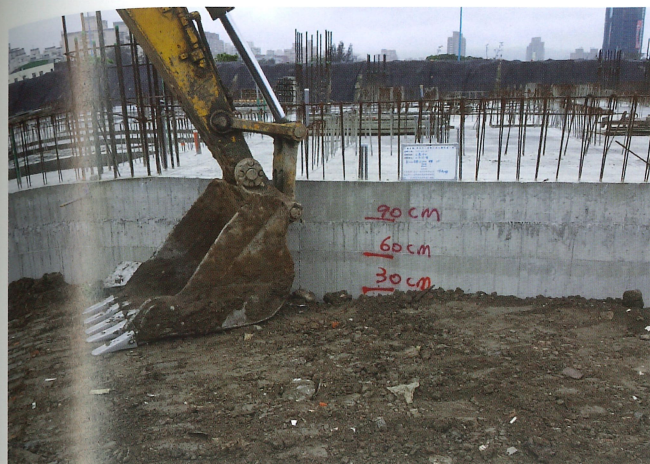
土方開挖回填施工照片
