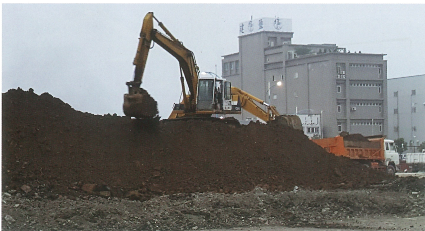
土方開挖回填施工照片
