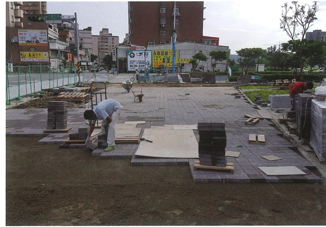
透水鋪面施工過程紀錄
