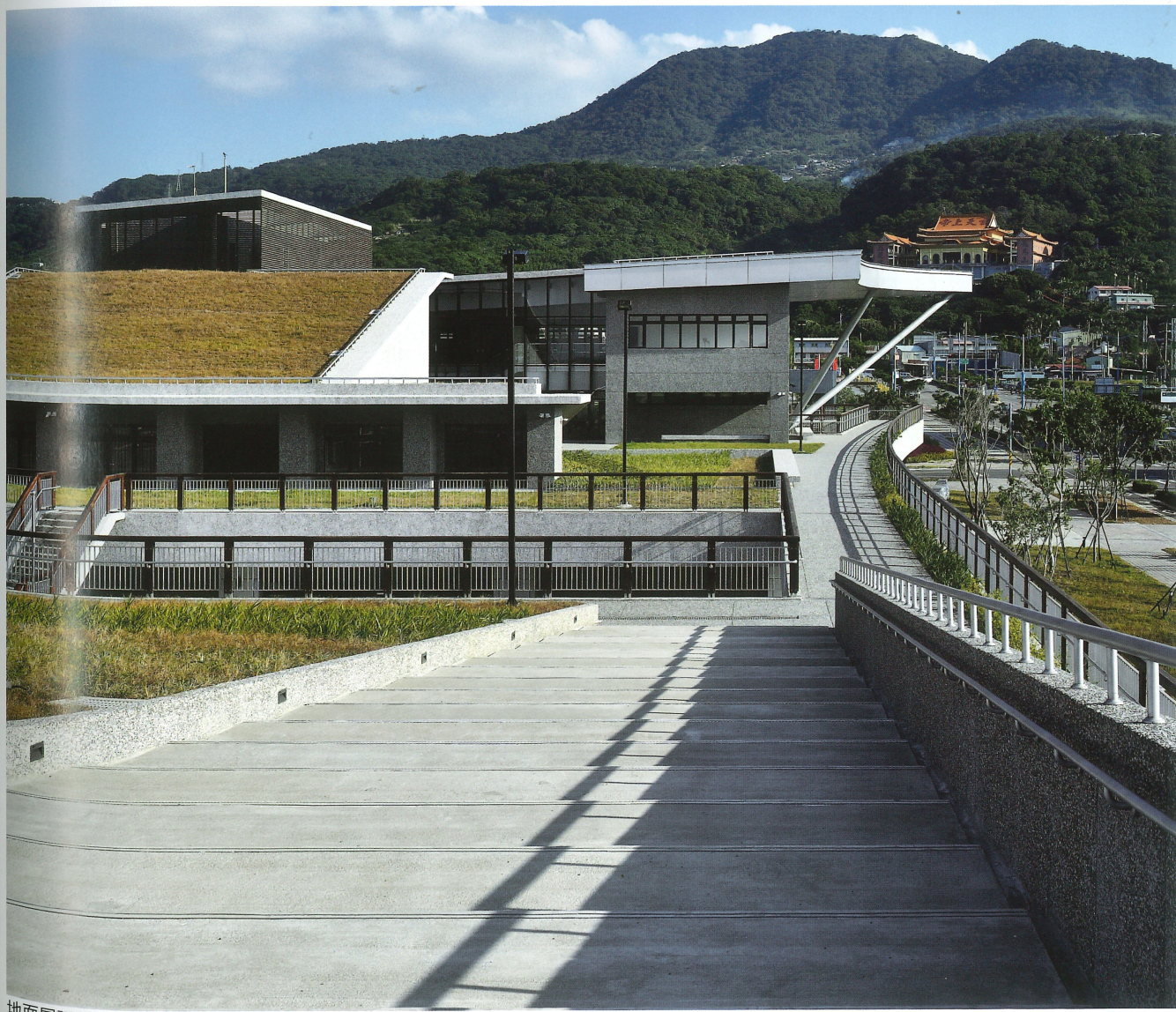
地面層延伸的屋頂公園，可眺望山海景觀。
