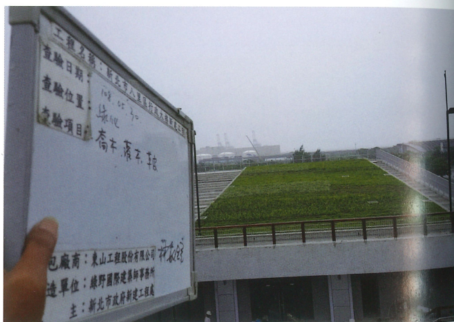
屋頂大規模綠化工程
