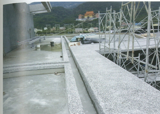
屋頂隔熱層竣工照片
