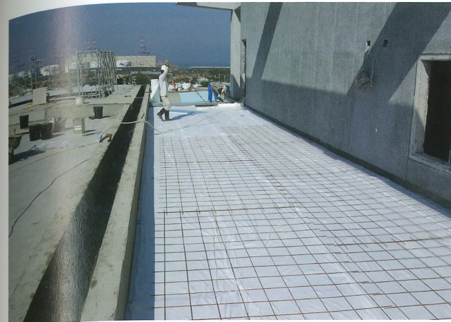
屋頂隔熱工程施工過程紀錄
